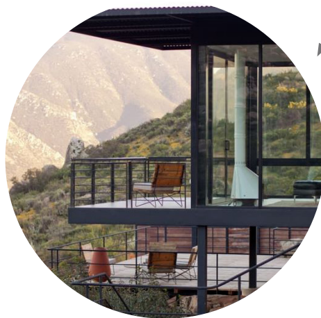
ESCTRUCTURA METÁLICA NEGRA
